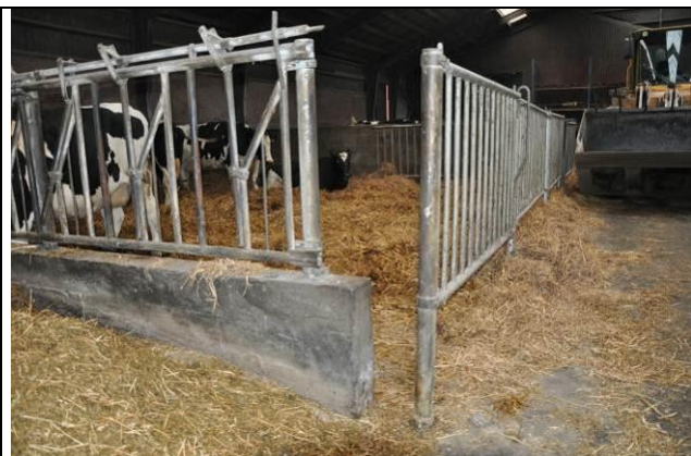
Figur x. Etablér mandehuller i fælleskælvningsboksen eller fælles højdrægtighedsområdet så let og hurtig personadgang er mulig.
